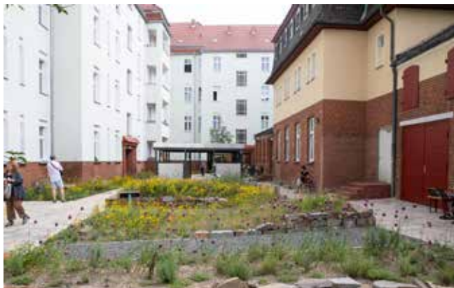
Bild 4 und Bild 5: vorher-nachher Aspekt Entsigelung Innenhof, Foto: Corinna Hölzer, Sebastian Runge
